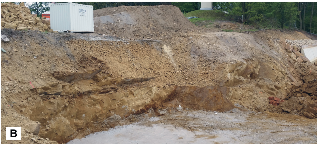
Abb. 1: A Panoramafoto der Baugrube, Blick nach NE. Die starke Rotfärbung im rechten Bereich ist auf eine Zone intensiver Eisenoxid/-hydroxid-Imprägnation zurückzuführen, die den hangenden Teil der Abfolge durchzieht. B Blick von oben in den nordwestlichen Teil des Aufschlusses. Aus diesem stratigraphisch tieferen Bereich wurden die meisten der Fossilien geborgen. (Fotos: Christian Höcker, Bielefeld).
