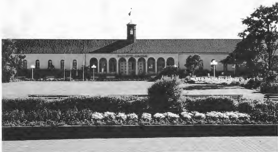
Abb. 43: Kuranlagen auf Norderney
