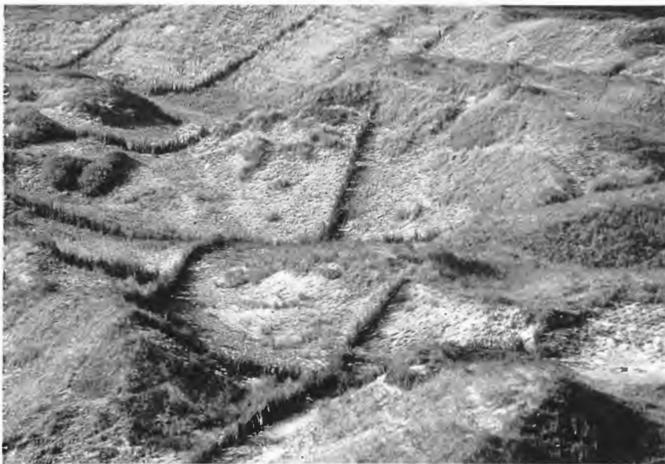
Abb. 71: Dünenfixierung mit Sandfangzäunen im Mittelteil von Norderney. Inzwischen konnte sich die Vegetation hier wieder weitgehend schließen.
