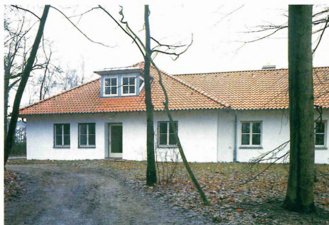
Die Außenstelle am Naturschutzgebiet "Heiliges Meer" nach Erweiterungs- und Anbaumaßnahme; Aufnahme 1992
