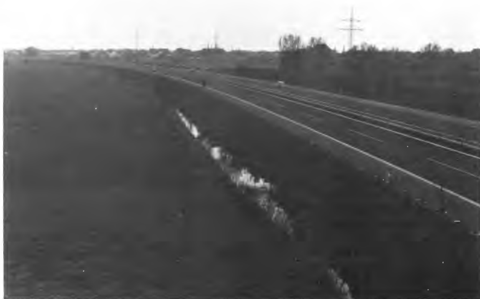
Abb. 40: Autobahnzubringer im Essenberger Bruch mit verlagertem Bruchgraben.
