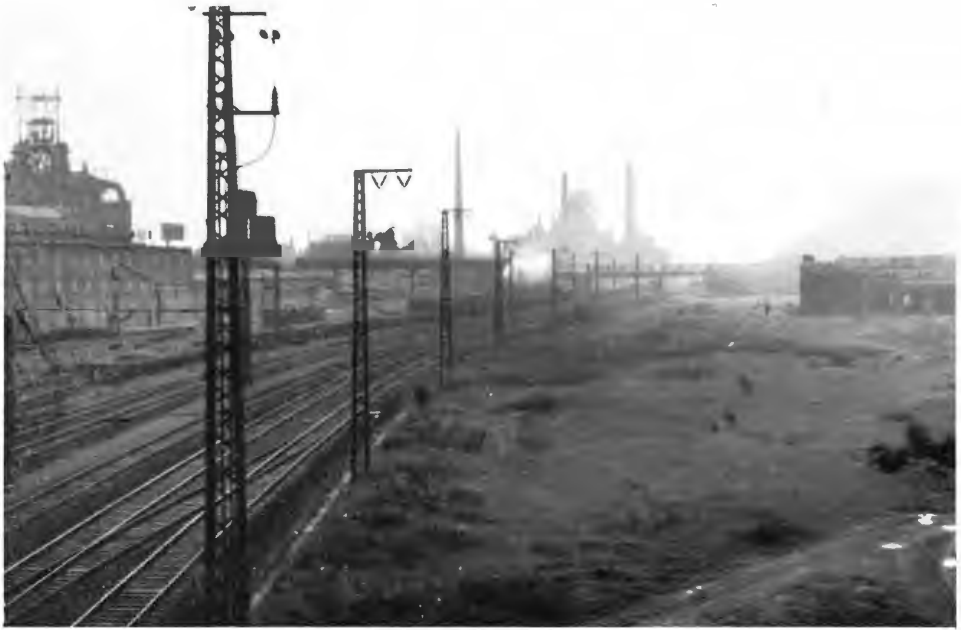
Abb. 24: Ausschnitt aus einem Industrierwerk mit Gebäuden, Gleisflächen und Ödland, im Hintergrund eine Halde. Brutbiotop für Hausrotschwanz, Steinschmätzer, Wiesenpieper und Schafstelze (W. Erz).
