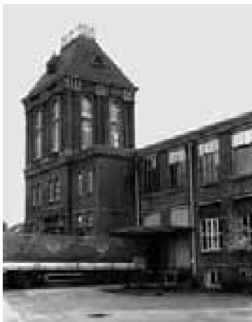
*Katoenspinnerij W. M. Bendix, Dülmen in Westfalen uit 1908, vroeg voorbeeld van betonskeletbouw met bakstenen afwerking*
