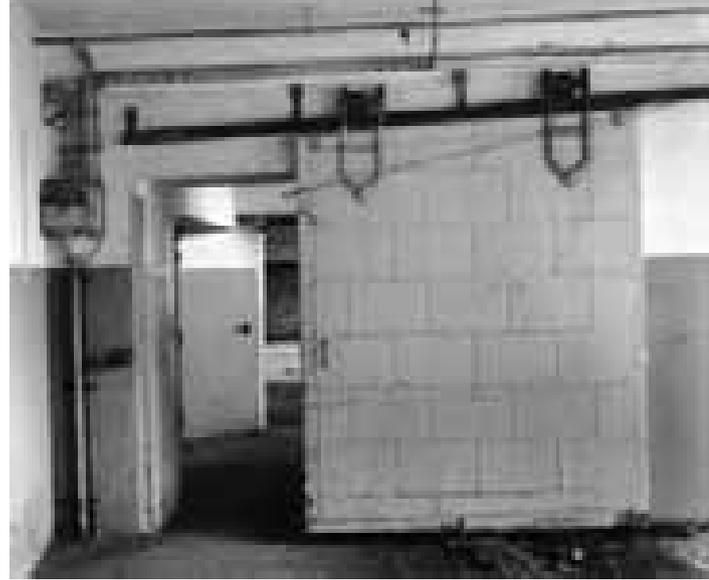
*Selbstschließende Feuerschutztüren werden zum Standard*
