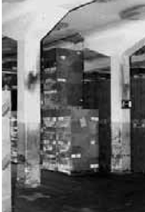
*Inwendige constructie uit staalbeton naar het systeem van Koenen met moerbalken in de lengterichting en licht gebogen vloervlakken, Katoenspinnerij W.M. Bendix uit 1908*
