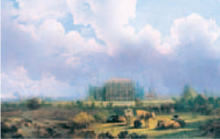
*'n Grootte Stoom torent als eerste mechanische spinnerij hoog boven de bescheiden Enschedese huizen uit. Het imposante gebouw met twaalf assen en vier verdiepingen werd in 1835 door G. Doorwaard Niermanns gebouwd en door de Engelse technici John und George Dixon met 12.500 spindels ingericht*
