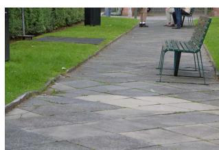
Mittelweg zur Alten Verwaltung
