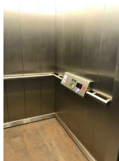
Bedientableau im Aufzug
