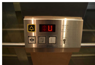
Aufzug Magazin zwischen EG und UG
