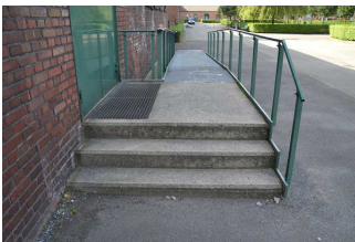
Treppe an Rampe beim Alternativen Eingang Lohnhalle
