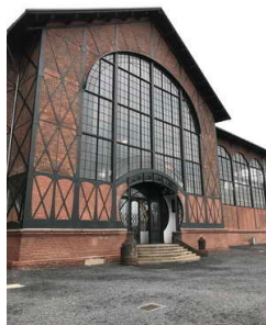
Blick vom Foyer/ Eingang Richtung Maschinenhalle
