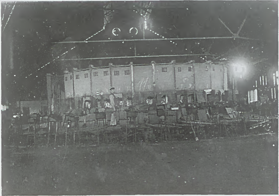
Abb. 11: Wanne VI, Innenraum. Eine der wenigen erhaltenen Aufnahmen aus dem Inneren eines Wannengebäudes der Glasfabrik, nach 1902.
