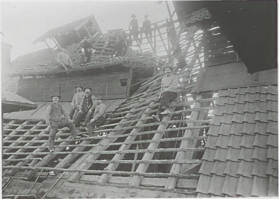
Abb. 13: Dacheinsturz der Wanne II, 17.1.1909.
