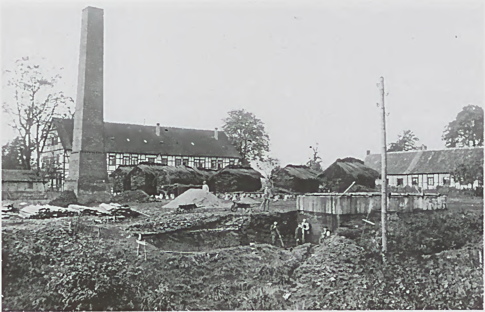
Abb. 28: Ehem. Glashütte Gernheim. Kamin der „Alten Hütte“, links im Hintergrund das Fabrikantenwohnhaus, rechts eine Arbeiterhauszeile. Im Vordergrund Weidenstapel für die Korbflechterei, die die Glasfabrik Wittekind in Gernheim betrieb. Aus einem Album, das Friedrich Borchard von Friedrich Jacobsen, dem Direktor der Glasfabrik Wittekind, Minden, zum 25jährigen Dienstjubiläum 1929 erhielt.
