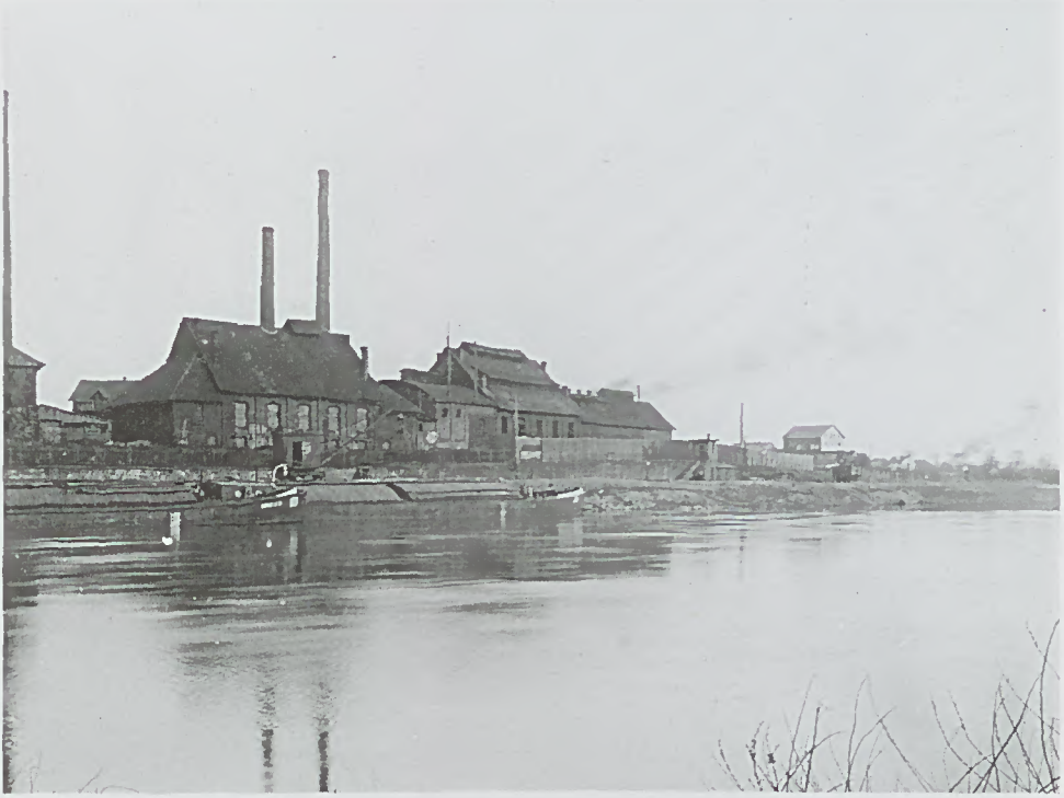
Abb. 1: Glasfabrik Wittekind, Minden, um 1890.
