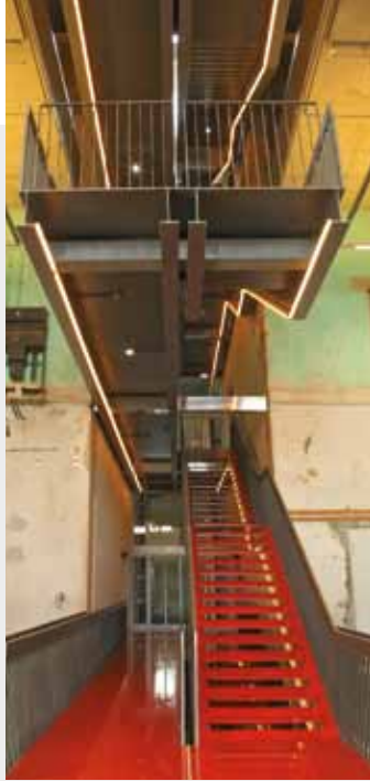
Een moderne trap verbindt de verdiepingen in de spinnerij
