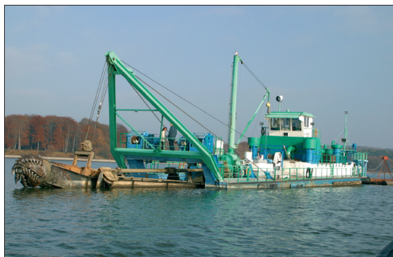
Abb. 3: Heutiger Schneidkopf-Saugbagger (Foto: GELSENWASSER AG)
