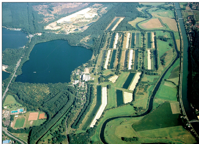
Abb. 1: Wasserwerk Haltern (Foto: GELSENWASSER AG)
