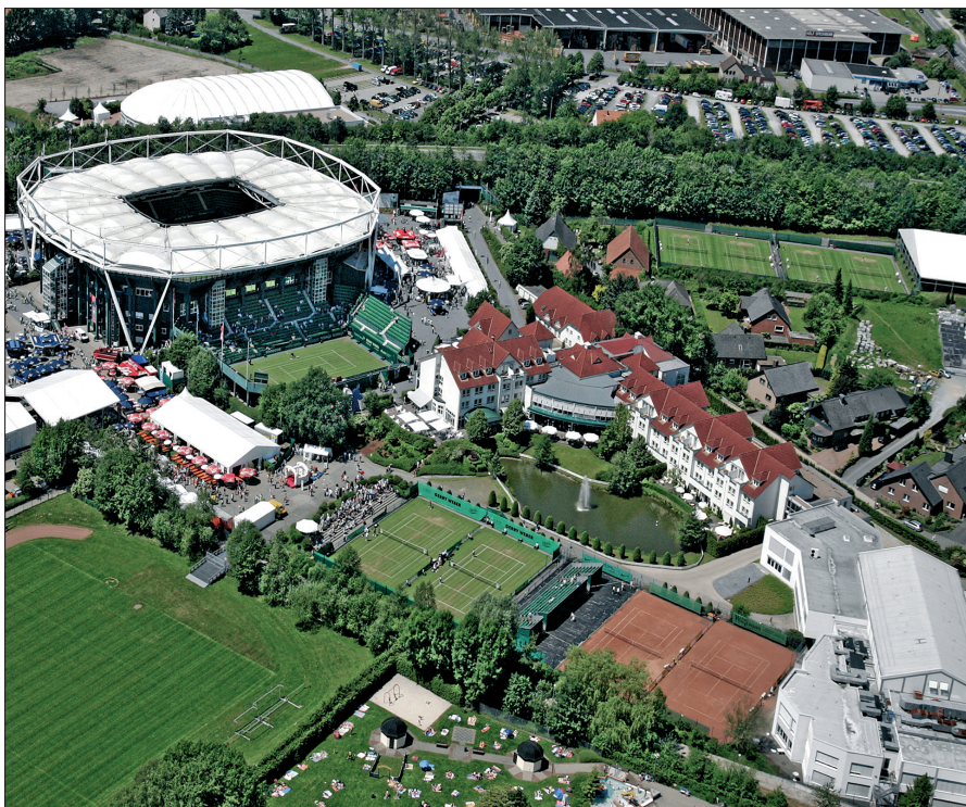
Abbn. 1 u. 2: Stadion, Hotel, Sportpark und Event Center in Halle/Westf. (Fotos: Gerry Weber World)
