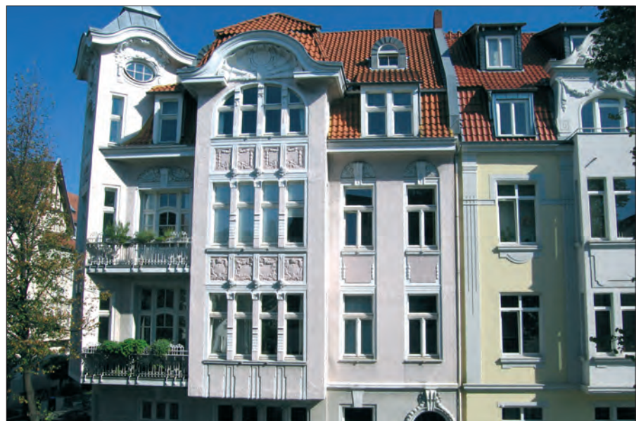
Abb. 1: Renoviertes Gebäude mit Jugendstilfassade an der Nordstraße/Ecke Raesfeldstraße (Foto: CHR. KRAJEWSKI)
