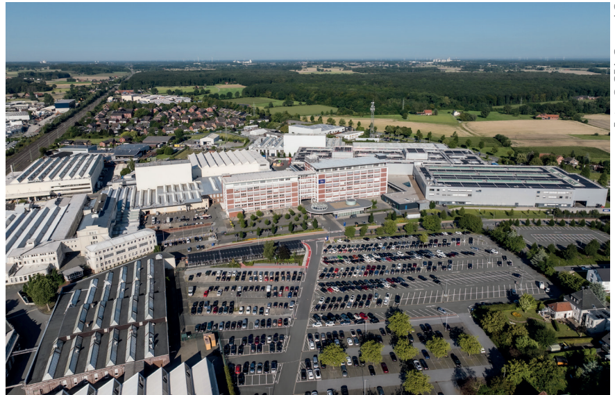
Abb. 3: GEA Westfalia Separator-Gelände, westlich der Oelder Innenstadt
