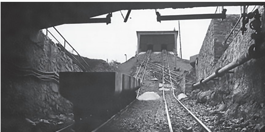
Abb. 1: Stolleneingang an der Tagesoberfläche („Mundloch“) des tonnlägigen Schachtes der Grube Wohlverwahrt, ca. 1939
