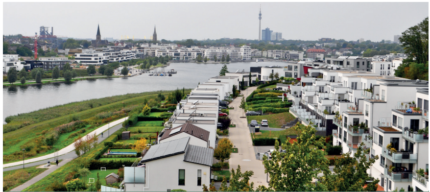
Abb. 1: Blick vom Kaiserberg auf den PHOENIX See mit Wohnbebauung am südöstlichen Ufer und dem Seequartier am westlichen Ende als städtebauliche Verbindung zu Alt-Hörde
