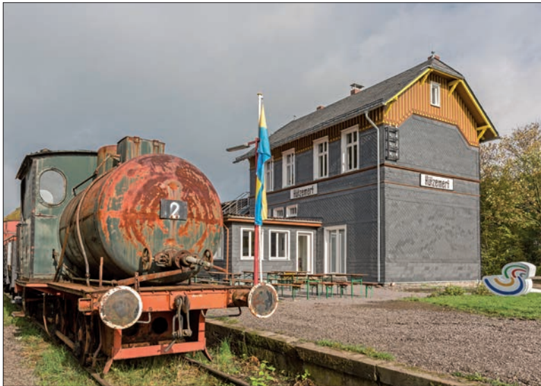
Abb. 1: Alter Bahnhof Hützemert (Foto: MICHAEL BAHR/Südwestfalen Agentur GmbH 2014)
