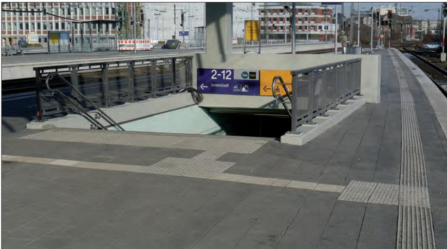
Abb. 3: Bahnsteig in Münster mit Leitstreifen und Aufmerksamkeitsfeldern. Die Bahnsteige sind über Treppen, Rolltreppen und Fahrstühle zugänglich (Foto: K. PAGENKOPF)
