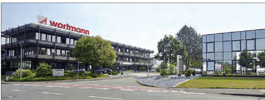
Abb. 2: Einfahrt zur Wortmann-Firmenzentrale in Detmold (Quelle: www.wortmann-group.com)
