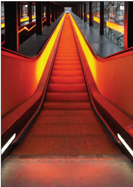
Abb. 3: Antriebstechnik made in Kückelheim: Die größte freistehende Fahrtreppe Deutschlands auf der Essener Zeche Zollverein läuft mit Ketten und Kettenrädern aus dem Sauerland (Foto: KettenWulf Betriebs GmbH)
