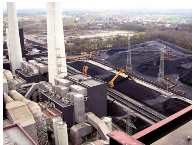
Abb. 2: Angelieferte Kohle und Teile des Kraftwerks Scholven (Foto: P. WITTKAMPF)
