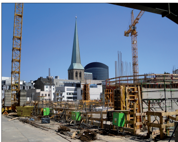
Abb. 5: Baustelle des Shoppingcenters Thier Galerie mit Petrikerkirche und RWE Tower im Hintergrund (Foto: F. SCHULTE-DERNE, 2010)
