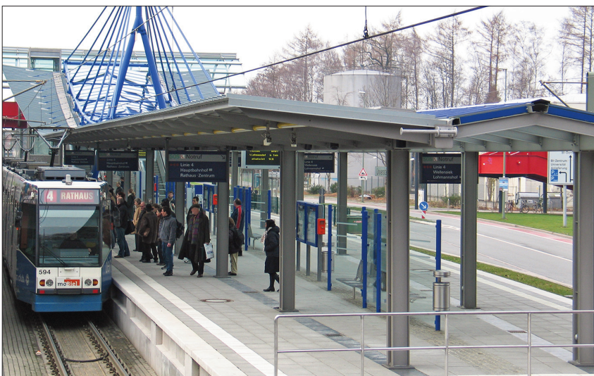
Abb. 1: Haltestelle „Universität“ der neuen Stadtbahnlinie in Bielefeld (Foto: moBiel)
