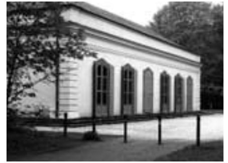
Ansicht der zwischen 1994 und 1997 restaurierten Konzertgalerie
