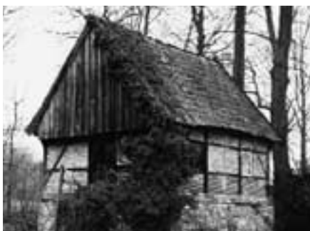
Speicher auf dem Hof Meinikmann, 1991
