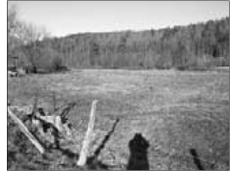
Verfallene Schleuse im Hauptzuleiter der Haus Büren'schen Flöbwiesen zwischen Ringelstein und Siddinghausen
