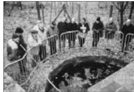
Besichtigung der in Beton gefaßten Quellschlotte des Mittelborn am Eiler Berg.
