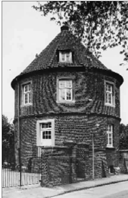
Der Pulverturm in Coesfeld.
