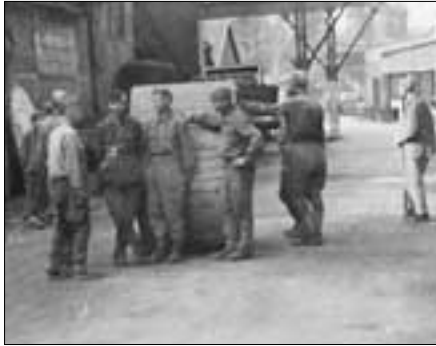
Zwangsarbeiter auf der Henrichshütte
