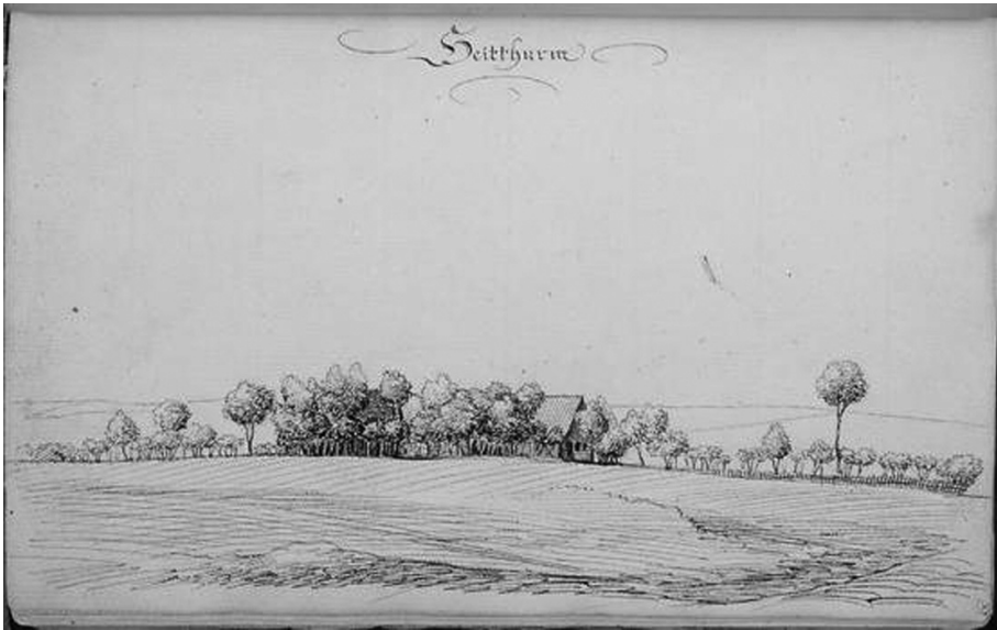
Abb. 5: F. J. Brand, „Heideturm“. Die Baumreihen rechts und links vom Gehöft markieren den Verlauf der Landwehr (AAV Pad Cod. 178, Pag. 39; „nach 1825“)
