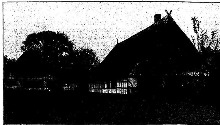
Abb. 14. Zweiständerhaus oder Rübungs Haus in Ummeln bei Albede mit „Kipp“ und Giebelgerden: Gek und Pferdetafel. Kipp = schräger Teil des Giebels.
