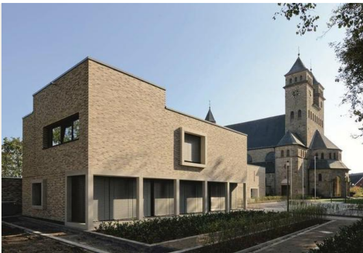
Neubau von Dienstwohnungen mit Pfarrverwaltung am Standort Filialkirche Herz Jesu, Emsdetten – Scholz Architekten BDA
