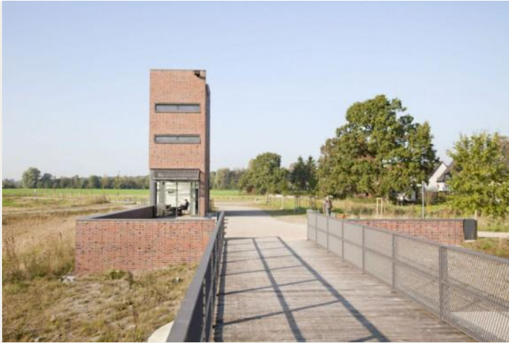
Das Betriebsgebäude und das Auslassbauwerk für das Hochwasserrückhaltebecken in Dortmund-Mengede und Castrop-Rauxel-Ickern.
