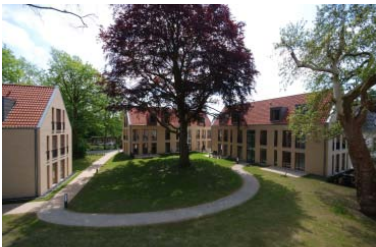
Die Bebauung des Houthschen Gartens in Burgsteinfurt wurde für ihr „städtebauliches und architektonisches „Feingefühl“ ausgezeichnet. Foto: LWL/Djahanschah
