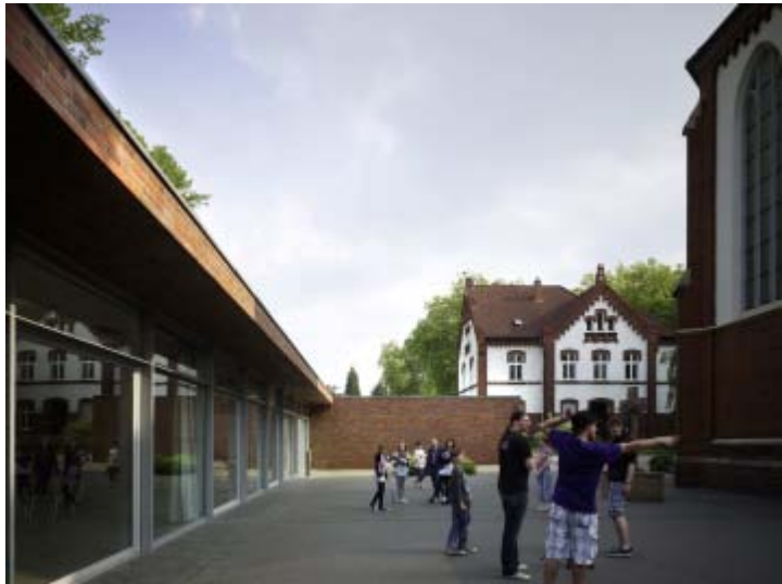
Das Pfarrzentrum St. Joseph in Herten, das die Kirche umschließt und so einen Innenhof schafft, ist erster Preisträger des Westfälischen Preises für Baukultur.
