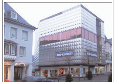
Alt-Bebauung: Kaufhaus Kölner Str. Foto: Stadt Olpe
