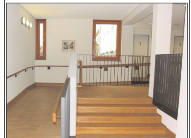
Grundschulerweiterung, Olpe-Rhode, barrierefreier Übergang Foto: LWL, Otto
