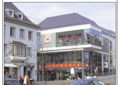
Neubau des Wohn- und Geschäftshauses -Neue Mitte-, Kölner Str. Foto: Stadt Olpe
