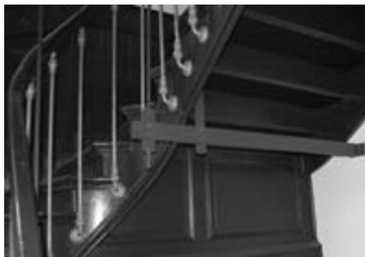
7 Stabilisierung der geschwächten Treppe mit einer Stahlkonstruktion, 2005.
