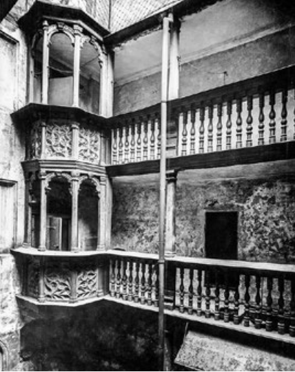
Abb. 2: Innenhof Bankgasse 7, kurz vor dem Abriss des Gebäudes aufgenommen; Foto: Hochbauamt, 1914 (StadtAN A 38 Nr. C-141-3)
