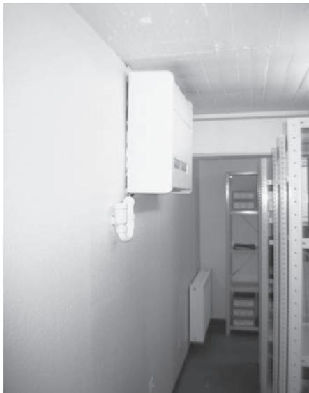
*Entfeuchter mit automatischem Abfluss
