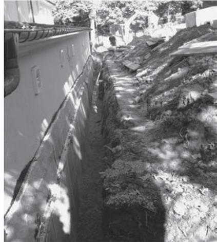
*Neu abgedichtete Außenwand des Magazintraktes*
