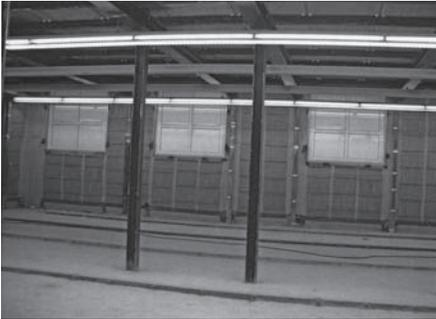
*Matten aus feinen Kunststoffröhren sind auf den Wänden angebracht worden. Dazwischen sind die gebündelten Zuleitungen sichtbar*
