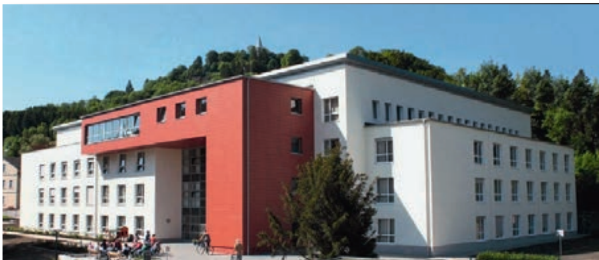
Neubau „Haus Stadtberge“
