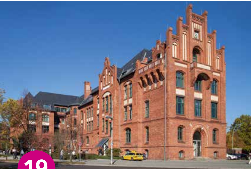
Das Verwaltungsgebäude der Firma Borsig in Berlin-Tegel ist ein typisches Beispiel für den Stil des „Backsteinhistorismus“.
