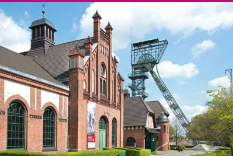
Alte Werkstatt und Fördergerüst
