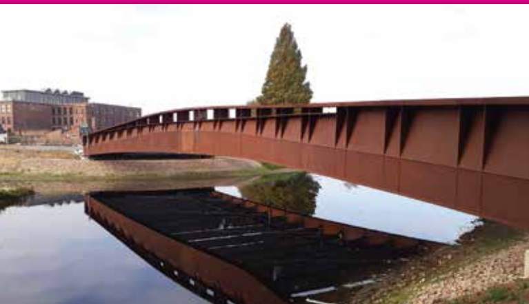
Eine Brücke aus Stahl spannt sich über den Fluss Aa. Im Hintergrund ist die Spinnerei zu sehen.
