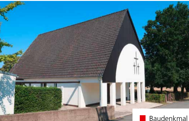
■ Baudenkmal in Westfalen mit typischer Architektur der 1960er-Jahre – Die Friedhofskapelle in Bad Holzhausen.
