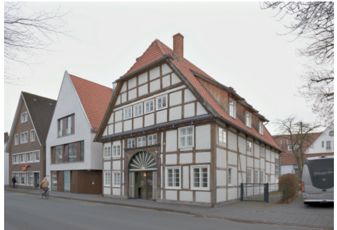
Das Renaissance Ackerbürgerhaus in Rheda-Wiedenbrück bekam eine Anerkennung.
