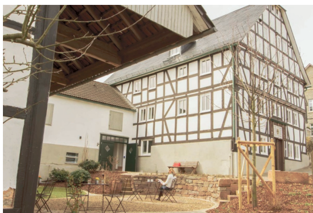
Der „Hof Hallenberg“ wurde mit dem Rheinisch-Westfälischen Denkmalpreis ausgezeichnet.
