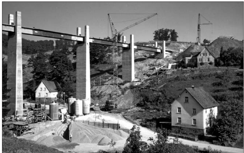
Rohbau der Stockwerkbrücke Dumicketal über den 1965 gestauten Biggesee mit Blick auf die später gefluteten Siedlungsgebäude. Foto: Hans Hild/LWL-Medienzentrum
