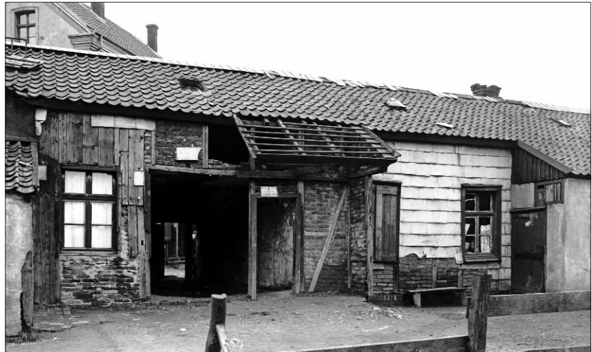
Bochum-Wiemelhausen: Baufälliges Backsteinwohnhaus mit Hofdurchgang, undatiert, 1920er Jahre
