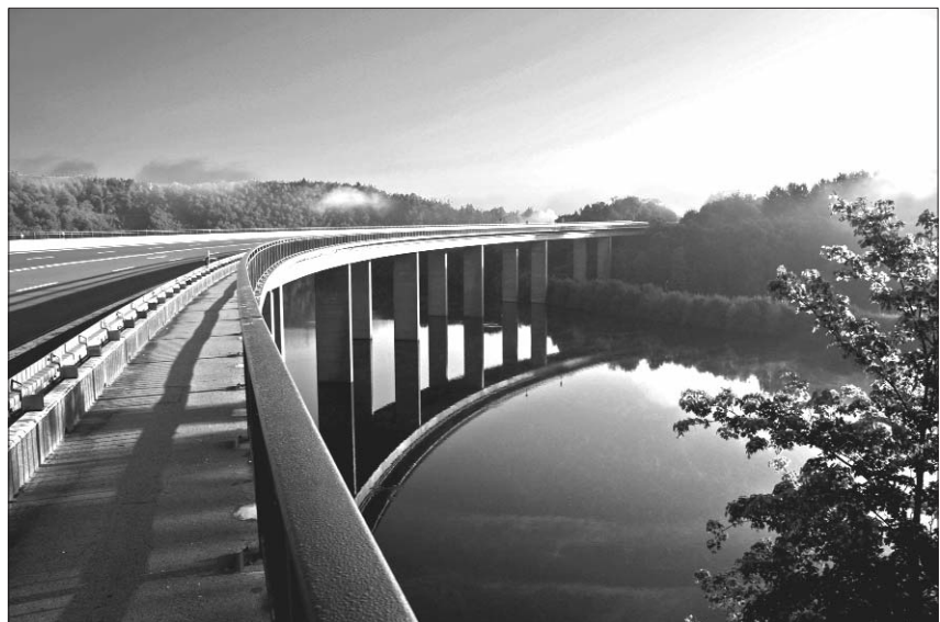
Die Ronnewinkeler Talbrücke über den Biggesee bei Olpe 2008 Foto: Sven Skultety/LWL-Medienzentrum
