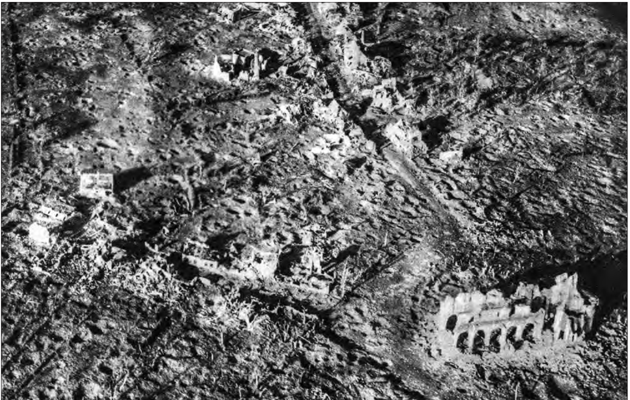
Luftaufnahme der völlig zerstörten Kirche in Passchendaele, ca. 1917 (Foto aus: George Soldan: Der Weltkrieg im Bild, Oldenburg 1926)
