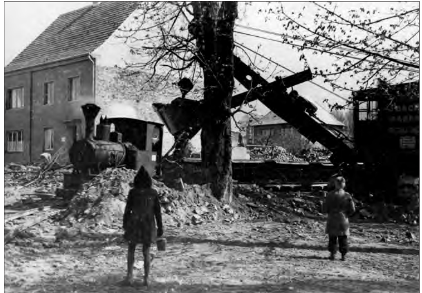
Trümmerräumung in Paderborns Kernstadt 1947 mit Trümmerbahn und Bagger. Foto: Stadt- und Kreisarchiv Paderborn.
