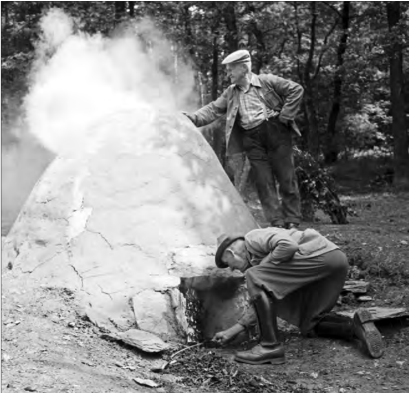
Anheizen eines rekonstruierten Eisenschmelzofens, Niederschelden/Siegerland 1961, Foto: Hans Hild/LWL-Medienzentrum
