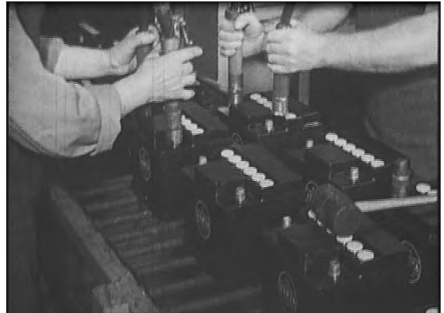
Fehlt das Netz, hilft nur noch die Batterie: Herstellung von Autobatterien bei VARTA 1972.
