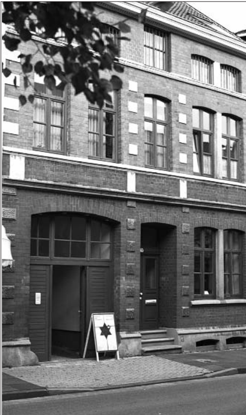
Vorderansicht des Frenkel-Hauses in Lemgo Foto: Museum Frenkel-Haus, Lemgo
