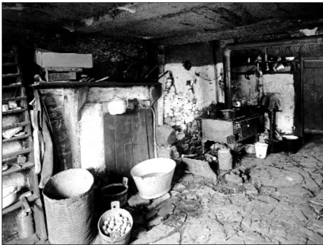
Herdstelle für zwei Familien in einem baufälligen Haus- oder Stalltrakt, Wenden (Kreis Olpe), undatiert, 1920er Jahre
