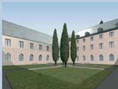
Blick in den Dalheimer Kreuzhof. Der links im Bild befindliche Südflügel der Klosteranlage soll während des zweiten Bauabschnitts wieder aufgestockt werden. Rechts im Bild: der bereits im ersten Bauabschnitt wiederhergestellte Westflügel
