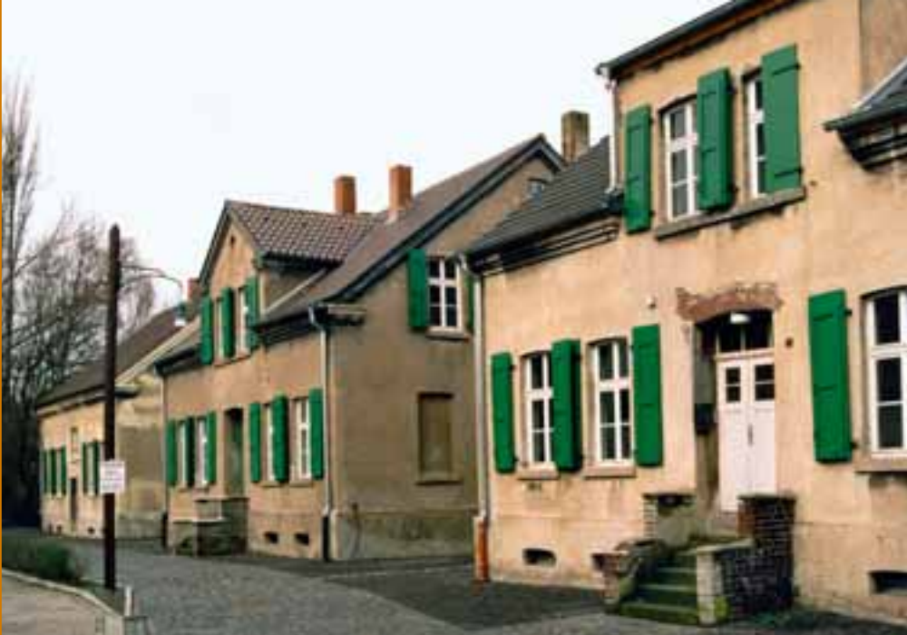
Die Bergarbeiterhäuser „Am Rübenkamp“
