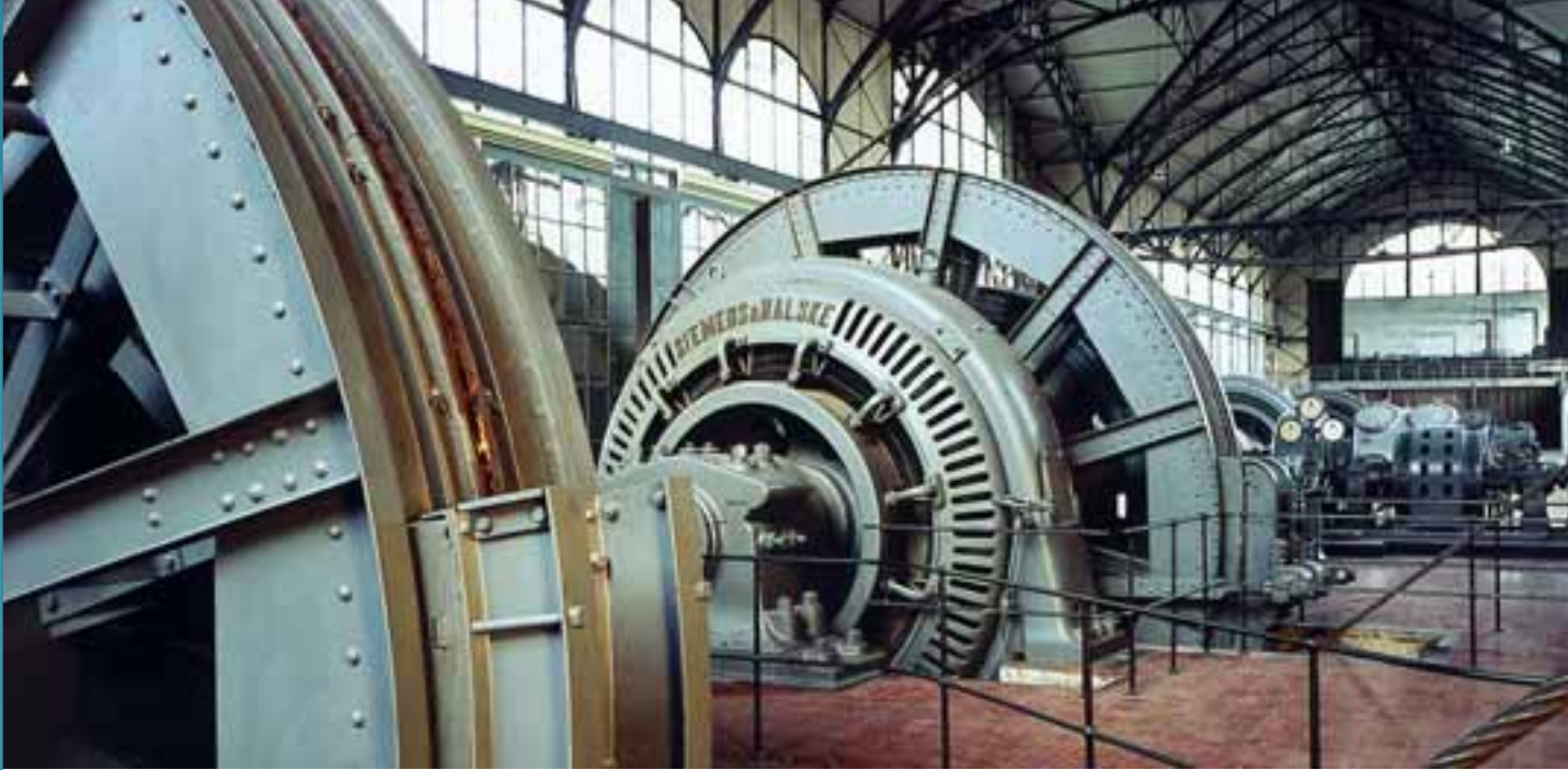
Die Maschinenhalle mit ihrer 100 Jahre alten Technik ist das Herz des ehemaligen Bergwerks
