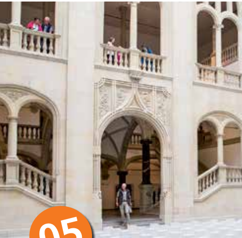
Der Lichthof im Altbau.
