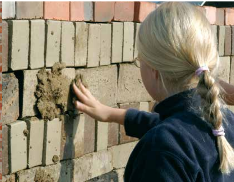
Der Feldbrandofen wird von außen mit Lehm zugeschmiert.
