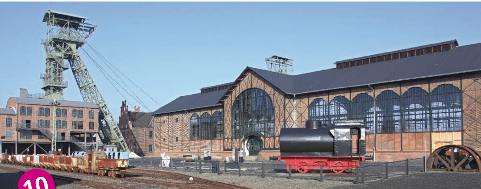
10 Zechenplatz mit Maschinenhalle und Fördergerüst.
