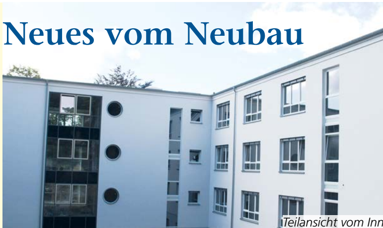
Teilansicht vom Innenhof aus.
